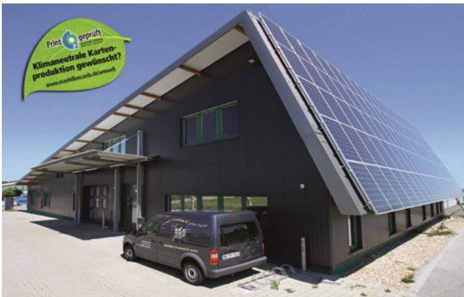
Eine 150 Quadratmeter große Photovoltaik-Anlage mit 100 Solarmodulen an der Südfassade des Firmengebäudes erzeugt jährlich 18.000 Kilowatt-Stunden (kWh) Energie.
